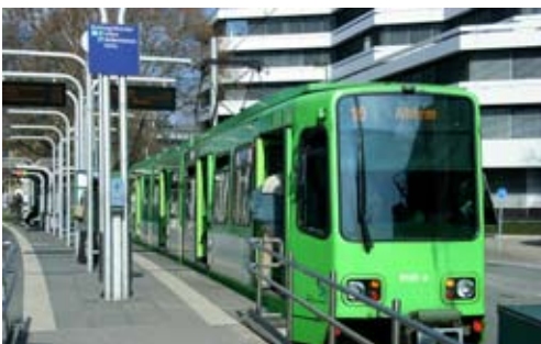
Hochbahnsteige sind nicht nur im Bau teuer, sondern oftmals störende Hindernisse
